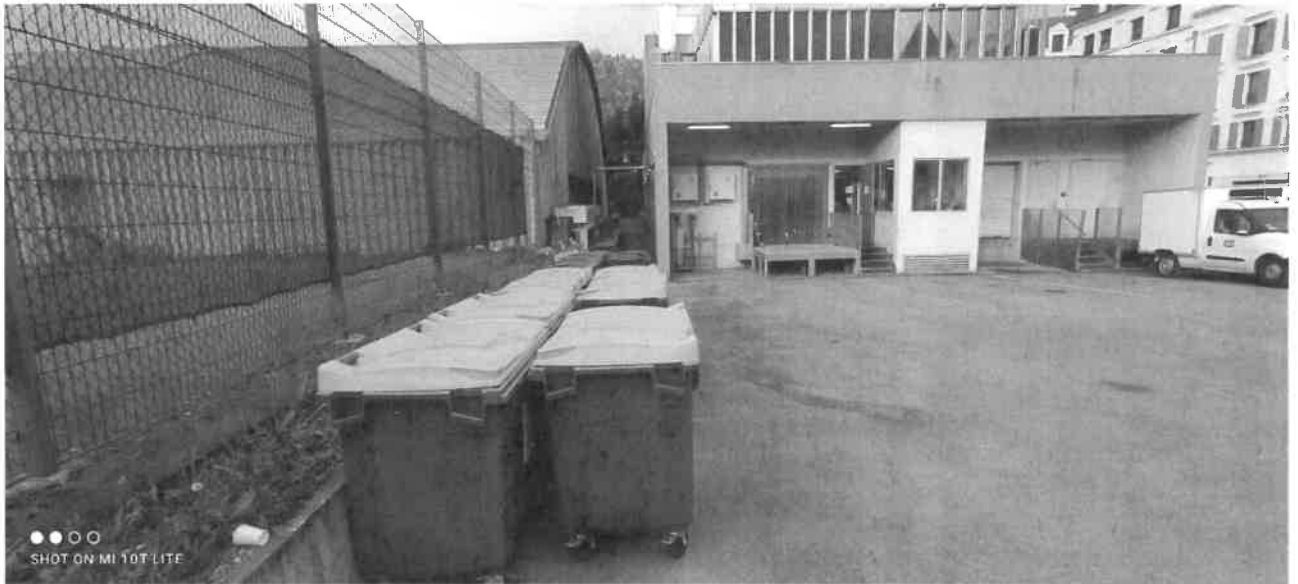
Le local déchets étant trop petit, les poubelles sont stockées à l'extérieur.
