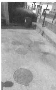
Le bac à graisse est prévu pour une cuisine de 1900 couverts / jour.
